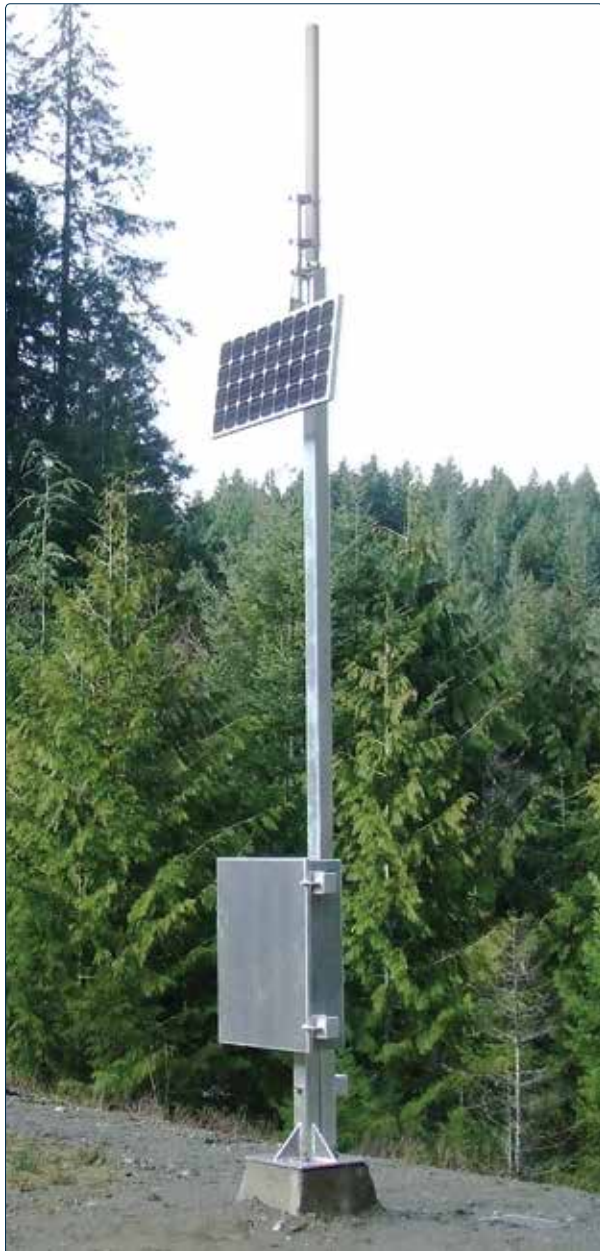
Gabinete con poste con panel solar y antena.
